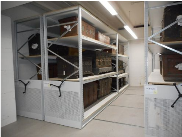
Weitspannregal (verfahrbar mit Fachbodenauflage aus Holzwerkstoff)
