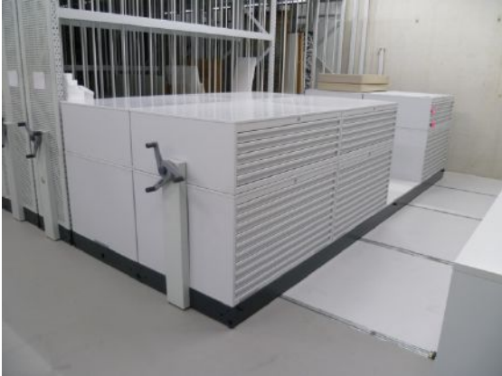
Grafikladen (Planschränke) verschiebbar im Hintergrund Fädelstäbe in Weitspannregal
